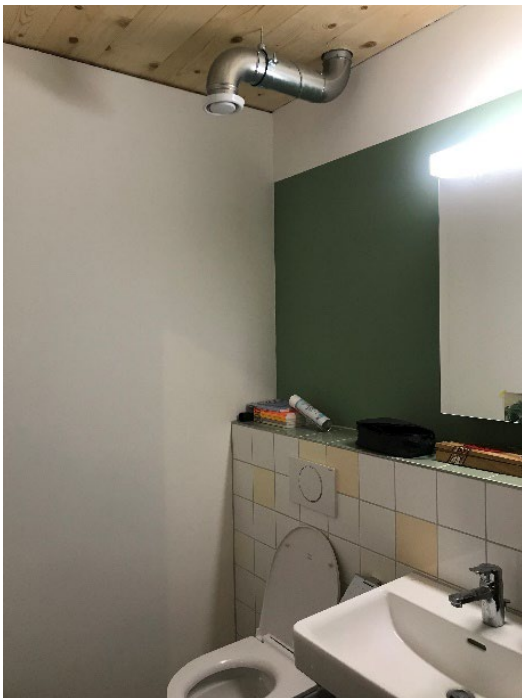
Abbildungen 30, 31, 32, 33, 34: Holligerhof 8. Innenansichten mit Beispielen zu sichtbar geführten Gebäudetechnikleitungen (Lüftung und Elektro)
