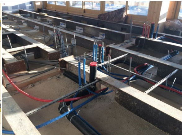
Abbildungen 26, 27: Schemaschnitt und Darstellung zum Hohlraumboden des Patch 22.
