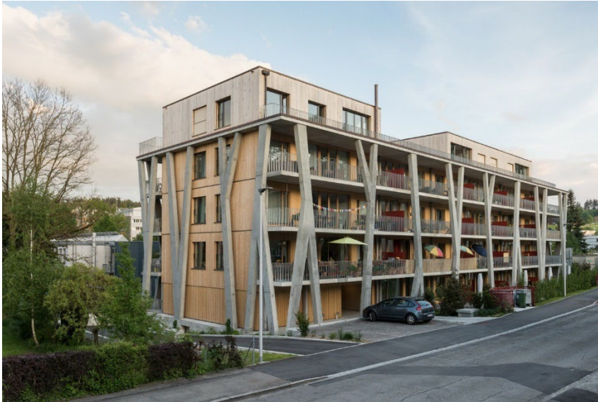
Abbildung 19: Holz-Beton Hybridbau Arborea in Bern.
