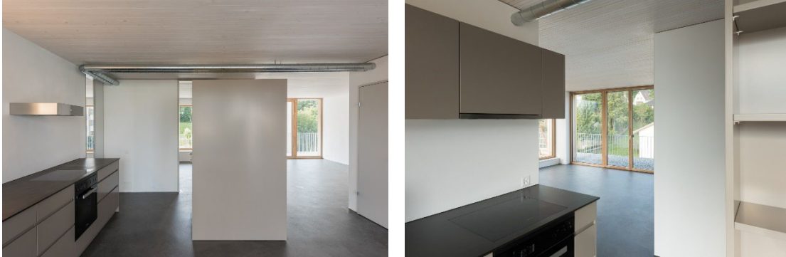
Abbildung 20, 21: Beispiele für offene Führung von Lüftungsleitungen in den Arborea-Wohnungen
