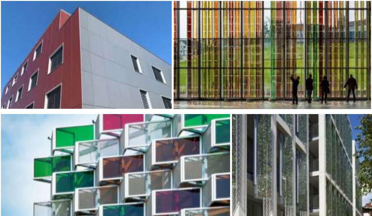
Abbildung 22: Beispiele für verschiedene Produkte für PV-Fassaden: MFH Seewadelstrasse, Affoltern am Albis: Produkte mit bedruckten, farbigen Frontglasabdeckungen und farbigen Zwischenschichten: Glas/Glas mit Mono-/Polykristallinen Zellen 5.13 W, Frontglas TVG strukturiert (Rosa504clear) 4 mm mit Digital-Keramikdruck. Einbettungsfolien EVA. Rückglas TVG 4 mm (links oben, Quelle: Viridén + Partner AG), SwissTech convention centre, EPFL Campus: Produkte mit farbigen und halbdurchsichtigen PV-aktiven Schichten: Farbstoffsolarzelle DSSC (rechts oben, Quelle: RDR / Fernando Guerra), Parkhaus, Vallastaden, Lindköping (Schweden): Fassadenelemente mit farbigen Verkapselungen unter Verwendung einer aktiven Schicht aus Cadmium-Tellurid (CdTe) (links unten, Quelle: Soltech Energy Sweden AB), Kingsgate House, London (Vereinigtes Königreich): Multikristalline c-Si-Solarzellen mit veränderter Dicke der AR-Beschichtung (auf dem Halbleitermaterial) (rechts unten, Quelle: David Langdon).
