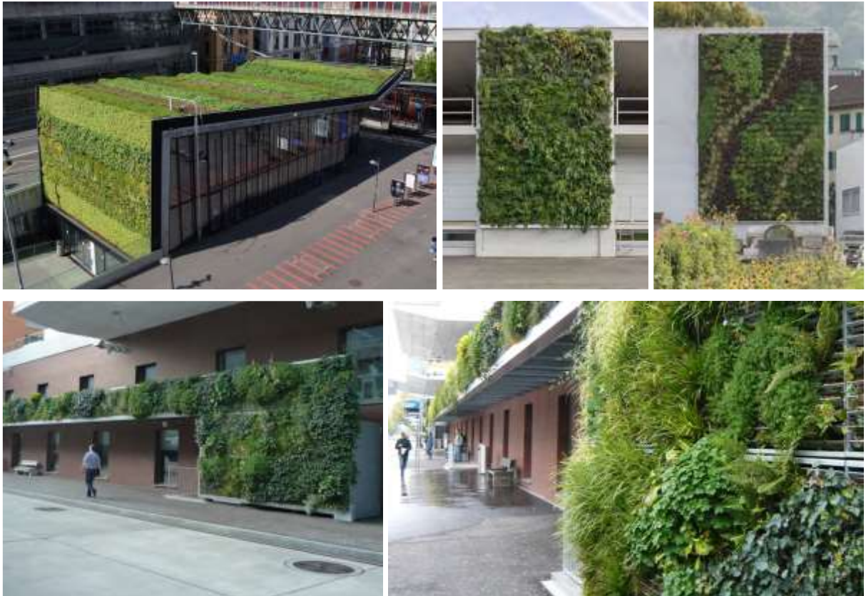
Abbildung 14: Beispiele für wandgebundene Fassadenbegrünungen: Kundenzentrum Flon – m2 Metro Station Lausanne: modulares, vorgehängtes, hinterlüftetes, wandgebundenes Begrünungssystem (links oben, Quelle: Nicolas Janberg), Stadtgärtnerei Zürich Fassadenbegrünung W+L: zwei modulare wandgebundene Systeme mit unterschiedlichem Bausystem und Vegetation (oben: mittig – modulares System – und rechts – flächige Konstruktion –, Quelle: raderschallpartner ag) und Zentrumsüberbauung MITTIM in Wallisellen: immergrüne Pflanzen in schrägen Bändern, kombiniert mit Blühpflanzen, gesetzt zwischen den Lamellen, die auf einer Stahlkonstruktion angeordnet sind (unten, Quelle: raderschallpartner ag).
