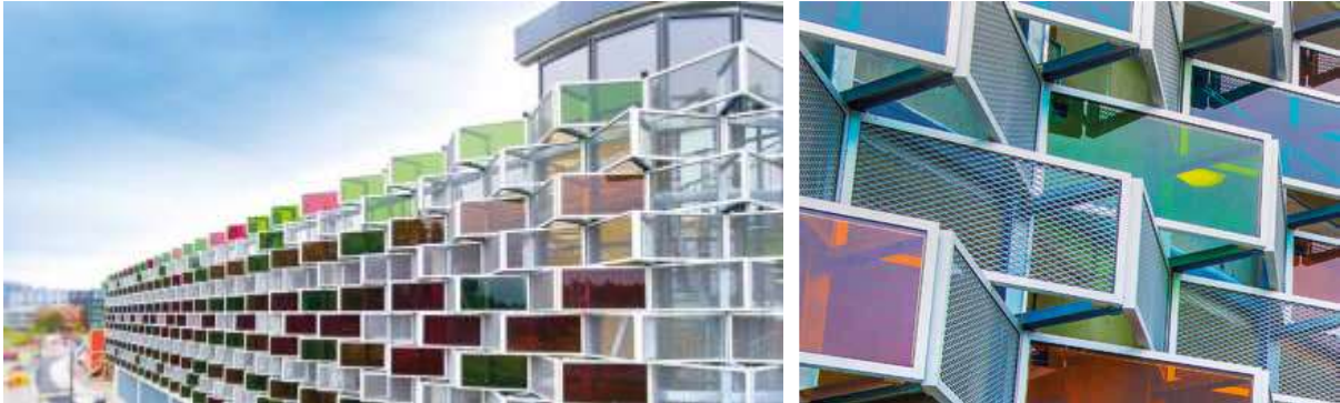
Abbildung 38: Parkhaus, Vallastaden, Lindköping (Schweden): Fassadenelemente mit farbigen Verkapselungen unter Verwendung einer aktiven aus Cadmium-Tellurid (CdTe)-Schicht (Quelle: Soltech Energy Sweden AB).
