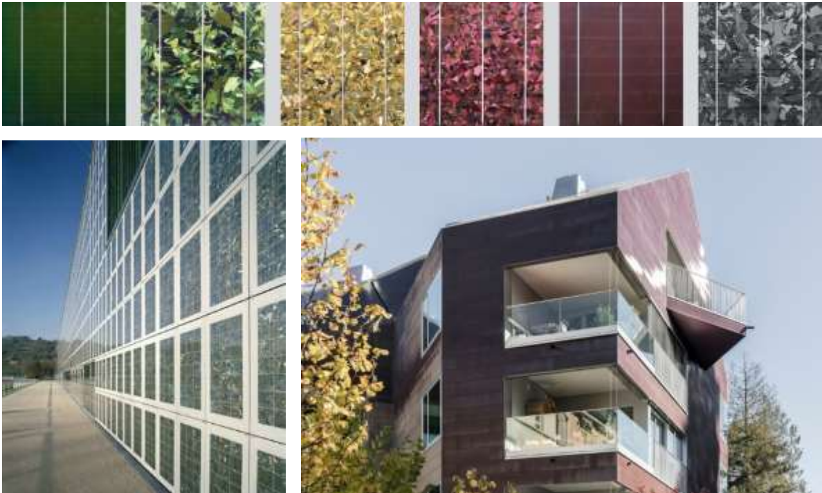
Abbildung 69: Gestaltungsmöglichkeiten von PV-Fassaden: verschiedene Farben und Muster von gebäudeintegrierten PV-Modulen (oben, Quelle: Solarnova), Paul-Horn-Arena in Tübingen (unten links, Quelle: Sunways/Ferit Kuyas), Wohnhaus Solaris, Zürich/CH – Architekten Huggenbergerfries (rechts unten, Quelle: Beat-Bühler).
