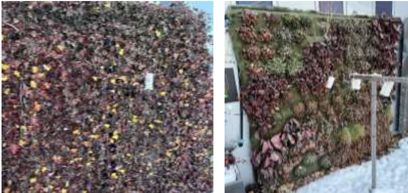
Abbildung 105: links, der Fassadenprototyp mit der bodengebundenen Begrünung im Winter; rechts: die wandgebundene Begrünung mit der Messinfrastruktur, ebenfalls im Winter.
