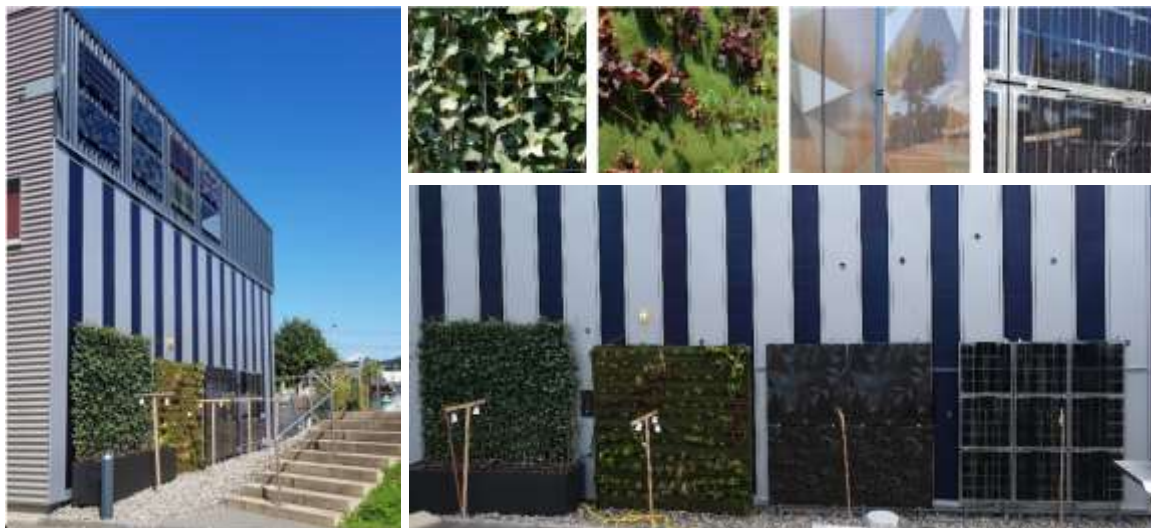
Abbildung 5: Messinfrastruktur an der Südfassade der Vegasin-Halle an der Hochschule Luzern Technik & Architektur.
