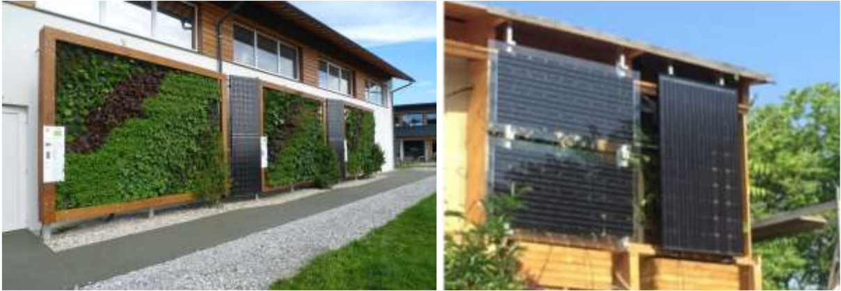
Abbildung 28: GrünAktivHaus in Großschönau, Österreich: Fassade mit horizontaler Kombination von wandgebundenen Begrünungsmodulen und PV-Modulen (links, Quelle: Uli Pitha) und "Öko-Prüfstand", TU Wien, Österreich: Kombination von Begrünung und PV «übereinander» (rechts, Quelle: María Soledad Penaranda Moren).
