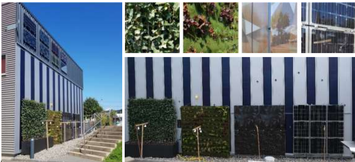
Abbildung 45: Messinfrastruktur an der Südfassade der Vegasin-Halle an der Hochschule Luzern Technik & Architektur.
