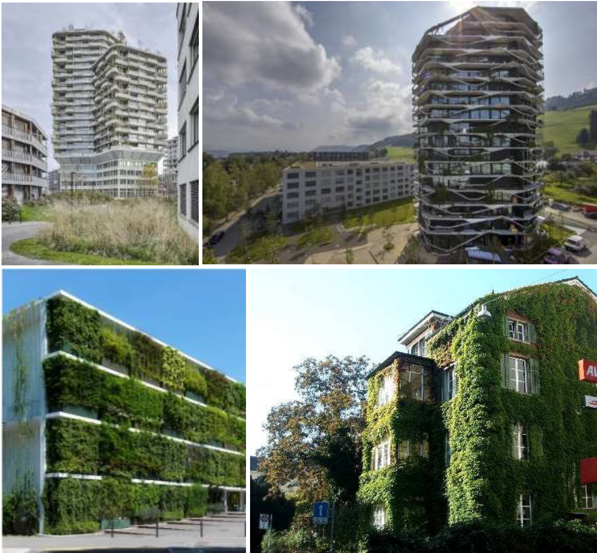
Abbildung 13: Beispiele für wandgebundene Vegetationsflächen in Pflanzgefässen und bodengebundene Fassadenbegrünung: Gartenhochhaus Aglaya in Rotkreuz: 50 Arten von Solitärbäumen, Heckenpflanzen, Sträuchern, Kletterpflanzen und Stauden in Trögen (links oben, Quelle: Christian Herbert Hildebrand), Garden Tower in Wabern bei Bern, Pflanzgefässe mit Kletterhilfe: diverse Pflanztypen wachsen aus den bodenbündigen Trögen in die Höhe mittels eines Edelstahlseilnetzes (rechts oben, Quelle: Beat Mathys), Stücki Einkaufszentrum in Basel: 23 verschiedene Gehölzarten und Kletterpflanzen (Schlinger und Winder, für Seile geeignet) als Unterpflanzung in Trögen auf einer separaten Rankkonstruktion (links unten, Quelle: Beat Breitenfeld) und Gartenhofstrasse 7 in Zürich: traditionell bodengebundener Direktbewuchs ohne Kletterhilfe (rechts unten, Quelle: Thomas Buehler).
