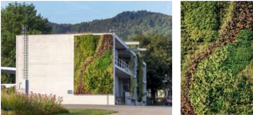
Abbildung 36: Stadtgärtnerei Zürich: flächig konstruiertes Textilsystem als leichte, vorgehängte Fassade mit substratgefüllten Vliestaschen, Nährstoff- und Bewässerungssystem sind integriert, gestaltetes Vegetationsbild mit Stauden in flächiger, linearer sowie punktueller Anordnung. Textil-System und Bepflanzung von Vertiko GmbH, Kosten: 1'900 Fr./m 2 (Quelle: NNBS.ch, Stadtgärtnerei Zürich).
