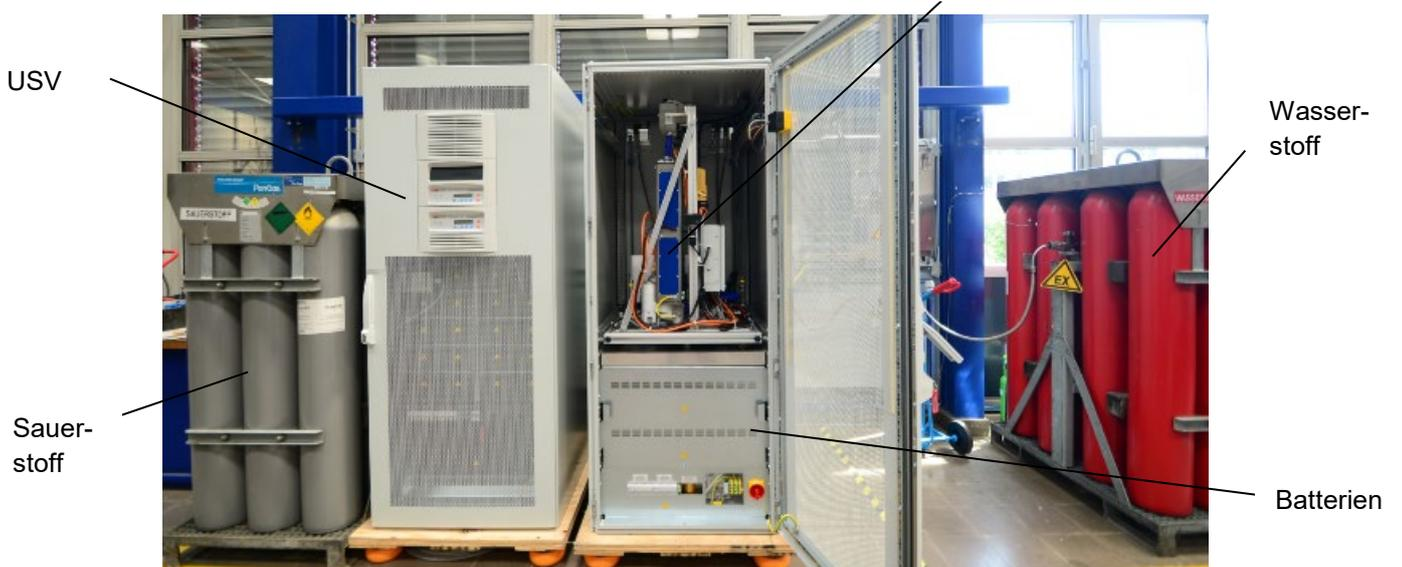
Abbildung 5: Aufbau der Anlage gemäss Systemarchitektur 1: Rack 1 mit den zwei UPS Modulen (links), Rack 2 mit Brennstoffzellensystem und Batterien (rechts).
