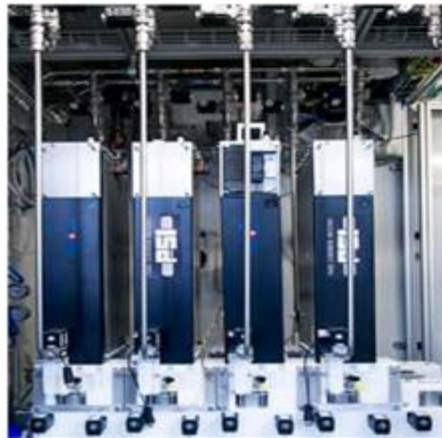
Abbildung 22: Einbau von vier Swiss Hydrogen Brennstoffzellen-Modulen mit neuem Design im ESI-Projekt
