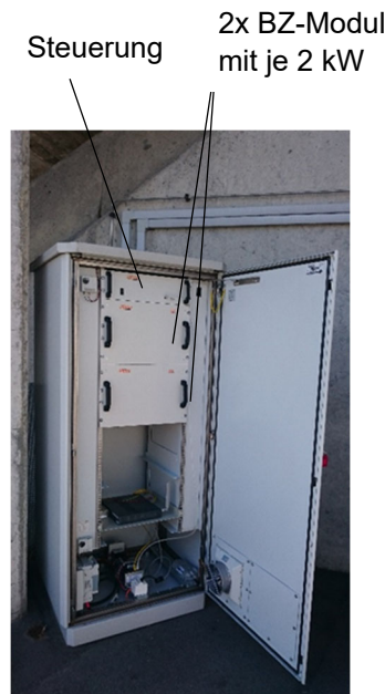
Abbildung 6: Brennstoffzelle 4 kW, Aussenaufstellung, Standort 4.
