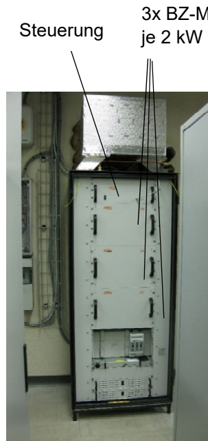
Abbildung 5: Brennstoffzelle 6 kW, Innenaufstellung, Standort 1-2.
