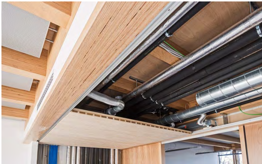
Abb. 25 - klare Systemtrennung zwischen Holzbau und Rohrleitungsführung in der dafür ausgewiesenen Deckenzone (Neubau euregon AG, lattkearchitekten)
