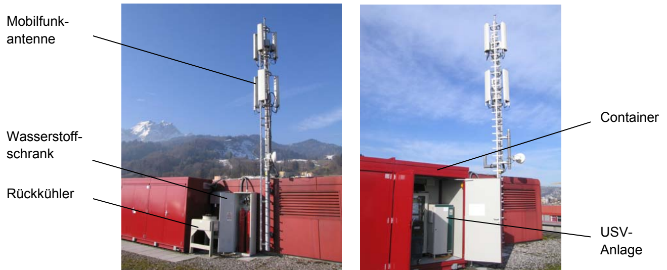
Abbildung 4: Aufstellung vor Ort mit Mobilfunkantenne
