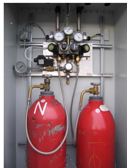
Abbildung 10: Wasserstoffversorgung mit Umschaltstation
