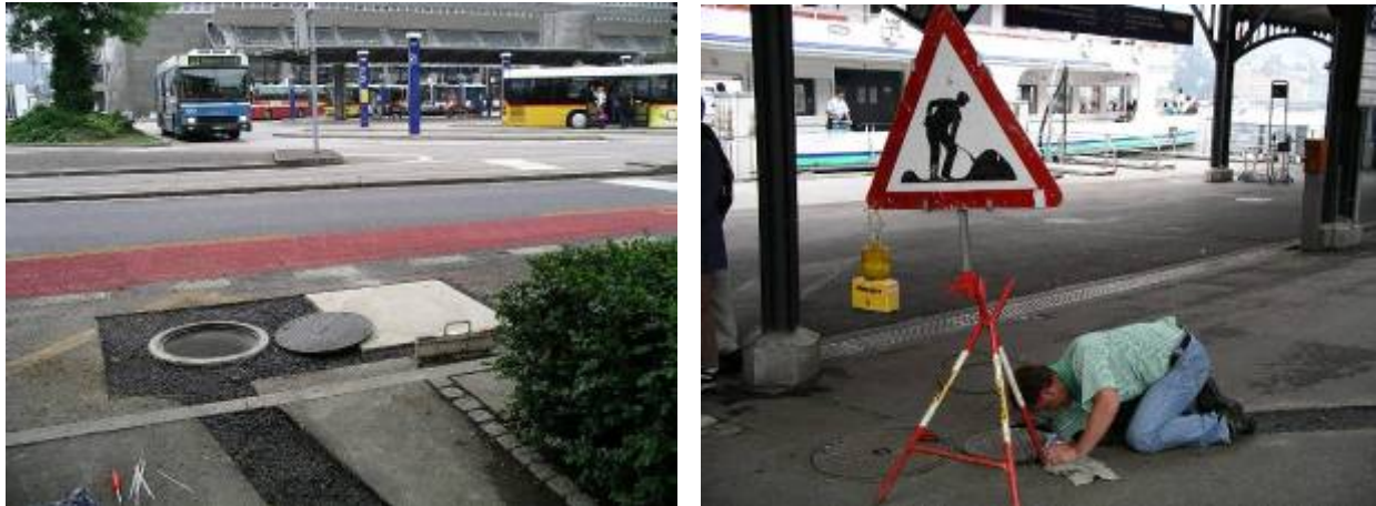
Abbildung 17 Arbeiten an der IPT Ladestation beim Bahnhof
