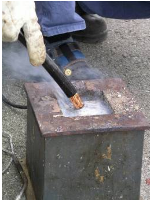
Abbildung 16 Verlöten der Kabelschuhe an den Hochfrequenzkabeln der IPT Ladeinseln.
