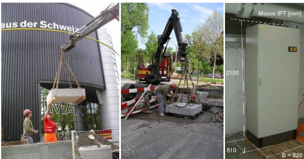
Abbildung 18 Arbeiten an der IPT Infrastruktur beim Verkehrshaus der Schweiz (IMAX)
