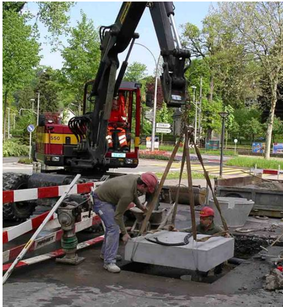
Figur 5: Einbau der IPT-Primärspule beim VHS
