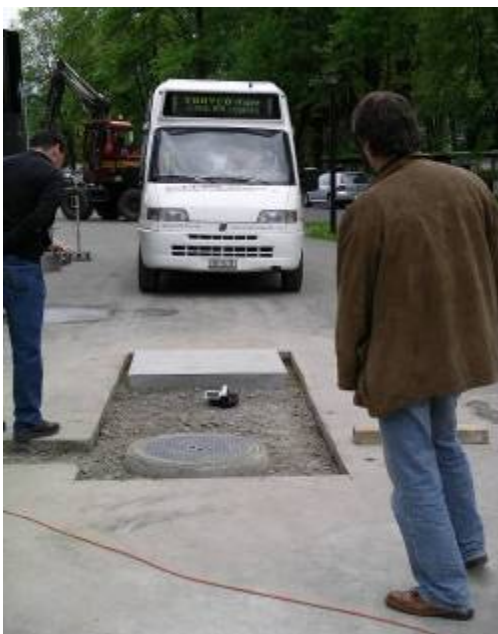
Abbildung 23 Inbetriebnahme IPT Ladestation beim Verkehrshaus
