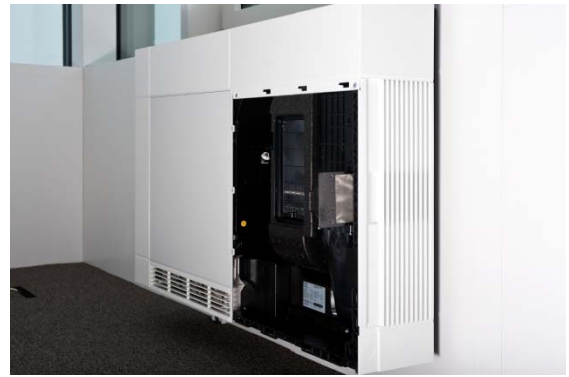
Abb. 4: Front AKLKK-900 ohne Abdeckung Elektrofilter Aussenluft mit Wärmetauscher
