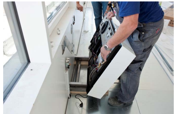
Abb. 6: Zugängliche Rückseite AKLKK-900 mit Befestigung der Komponenten im Chassis
