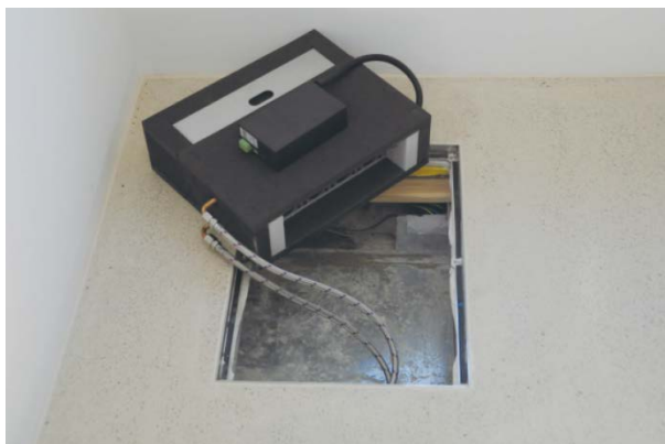
Abb. 6: Einbau der Airbox in die Installationsbox
